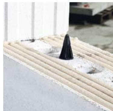
Le mortier est appliqué en couche mince à l'aide d'une luge à mortier. L'épaisseur du joint est d'environ 2 mm.
