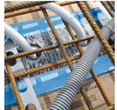
À l'issue des travaux de maçonnerie, on peut introduire correctement des conduites de câbles dans les canaux prévus à cet effet.
