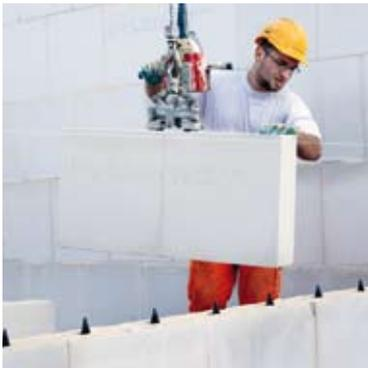
À l'aide de la mini-grue, une personne peut poser jusqu'à 0.5 m<sup>2</sup> de mur par portée. Les blocs sont posés bout à bout sans mortier de jointoiment. Des goujons de centrage assurent l'alignement des canaux techniques.
