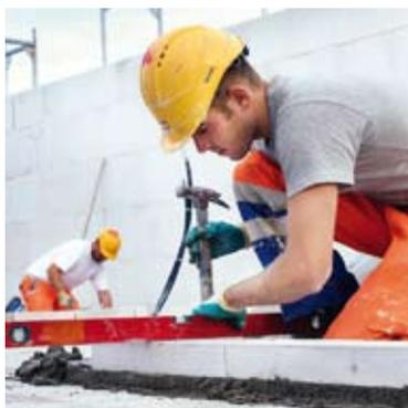
Le montage des briques commence par une couche de compensation afin d'obtenir une surface parfaitement plane.
